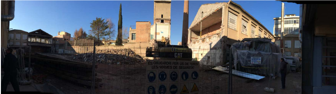
Situació de l'enderroc vista des de la portalada del carrer d'Alemanya
