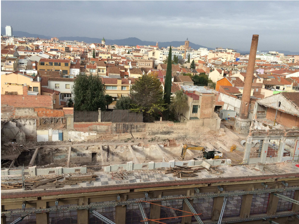
Vista de la nau conservada, la nau enderrocada, la xemeneia conservada i les parets mitjaneres amb els patis del veïnat
